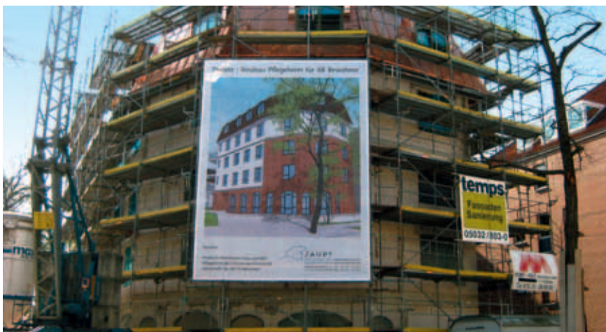
Das noch im Bau befindliche neue Friedrich-Rittelmeyer-Haus soll im September 2011 eröffnet werden.
